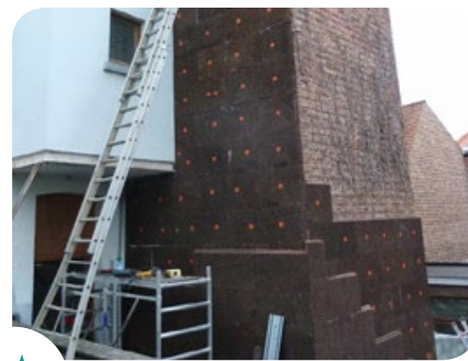
Isolatie aan de buitenkant of isolatie aan de binnenkant: er bestaan verschillende oplossingen. Meer info op de Ecobouwers Opendeur...
